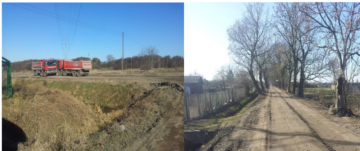
Ryc.3. Efekt zraszania drogi
